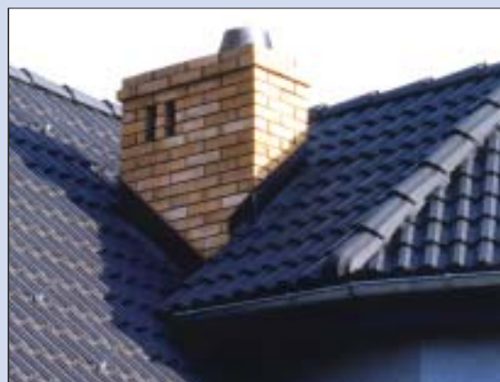
3 W tym kominie mieści się przewód spalinowy (widoczny stożek) oraz dwa wentylacyjne (widoczne otwory wylotowe) (fot. Schiedel)
