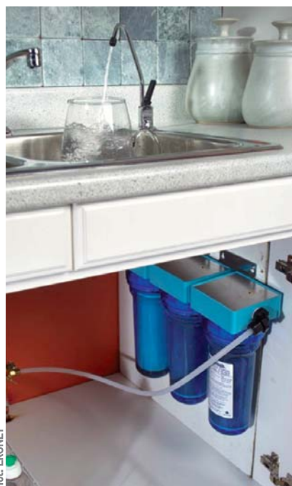
▲ Zestaw filtrów do odwróconej osmozy z pojemnikiem i taki do montażu w szafce pod zlewozmywakiem
