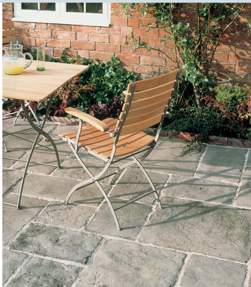
▲ Taras na gruncie jest najtańszy i najmniej kłopotliwy. Najczęściej wykańcza się go płytami kamiennymi lub kostką betonową
