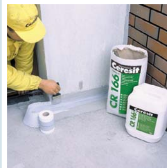
Miejsce styku tarasu i ściany uszczelnia się specjalną taśmą zatapianą w płynnej izolacji
