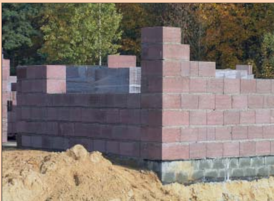
14 Budowa ścian nośnych z pustaków keramzytobetonowych (fot. Betard)
