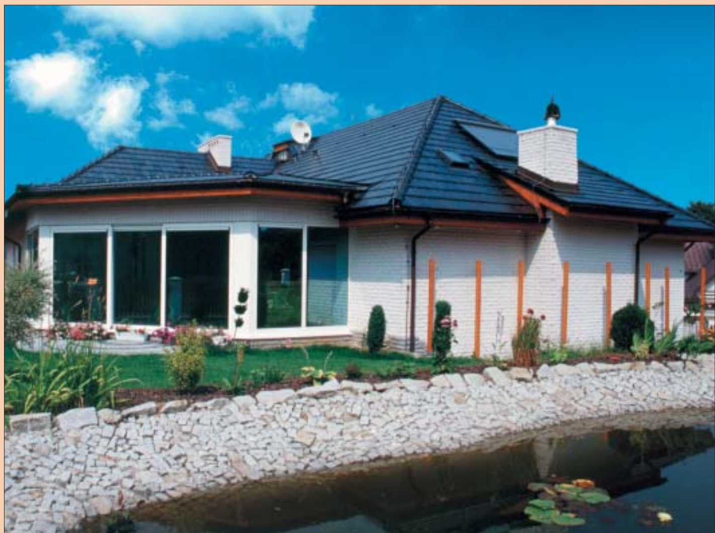
11 Elewacja z łupanych cegieł wapienno-piaskowych to znakomita alternatywa dla klinkieru (fot.Xella)
