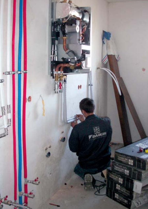
▲ Montaż jednostki wewnętrznej pompy ciepła powietrze-woda
