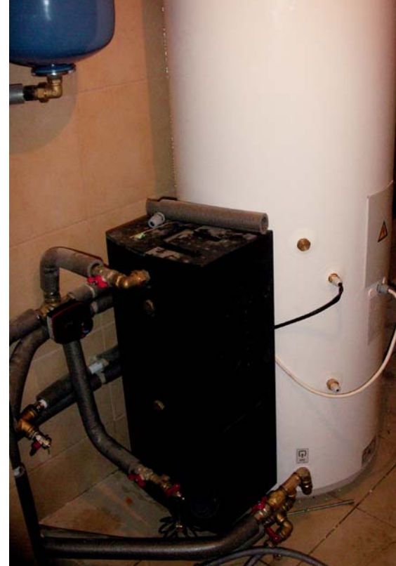
▲ Solar kit umożliwiający współpracę powietrznej pompy ciepła firmy Daikin z panelami słonecznymi
