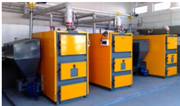
Kaskada 3xBioplex HL (122 1kW)
