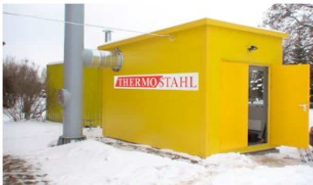
Kotłownia kontenerowa BIOPLEX HL 350 kW
