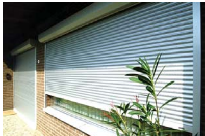
Rolety zewnętrzne zamontowane na wszystkich oknach mogą znacząco ograniczyć straty ciepła
