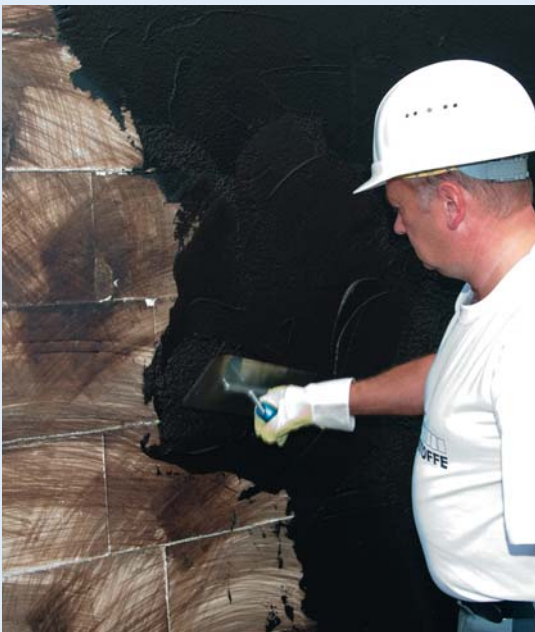
Masy bitumiczne nakłada się w kilku warstwach
