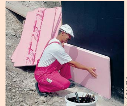
Polistyren ekstrudowany bardzo dobrze zabezpiecza ściany fundamentowe przed stratami ciepła, niestety jest drogi
