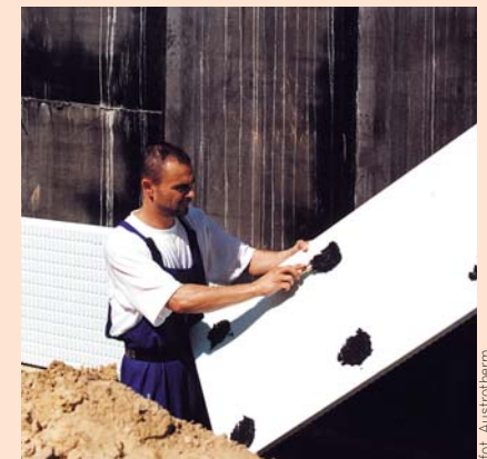
Styropian jest najtańszym materiałem termoizolacyjnym, wystarczająco dobrym również do ocieplania fundamentów
