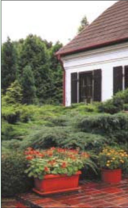
5 Nawierzchnia z klinkieru (fot. A. Kulikowska)
