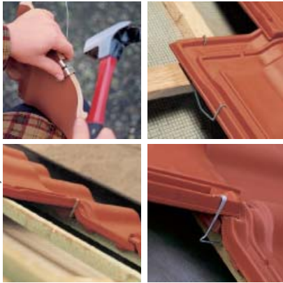
▲ Klamry do mocowania dachówek. Zabezpieczają je przed zsunięciem i poderwaniem przez wiatr
