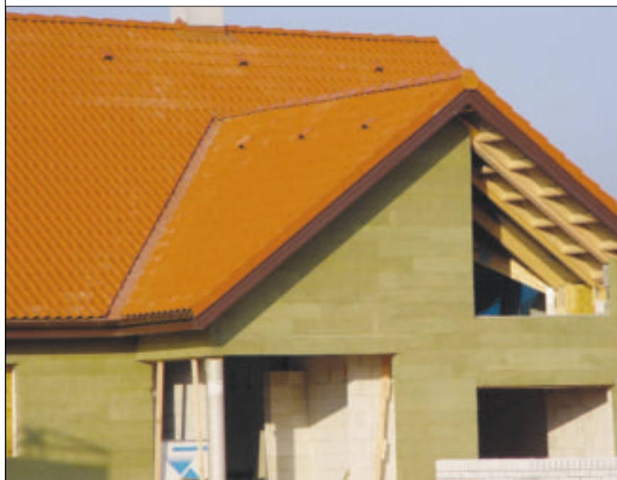
2 Wełna mineralna jako ocieplenie w metodzie lekkiej mokrej (fot. Rockwool)
