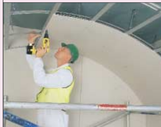
7 Płyty elastyczne mocuje się do specjalnych łukowych stelaży (fot. Lafarge Nida Gips)
