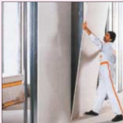
8 Płyty gipsowo-włóknowe są fabrycznie gruntowane. Od razu po zamontowaniu można je malować lub tapetować (fot. Fels-Werke)
