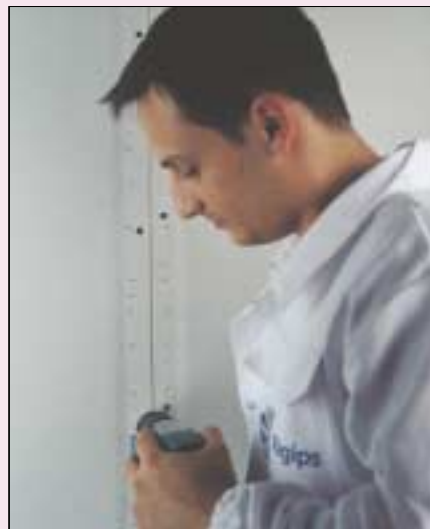
1 Płyty z miarką znacznie ułatwiają montaż (fot. Rigips)
