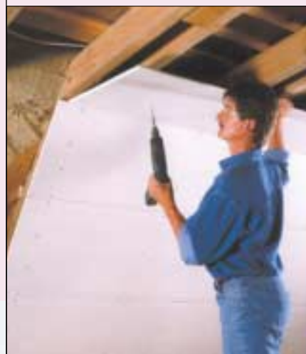
2 Zwykłych płyt gipsowo-kartonowych i płyt gipsowo-włóknowych używa się najczęściej do wykańczania poddaszy... (fot. Knauf)
