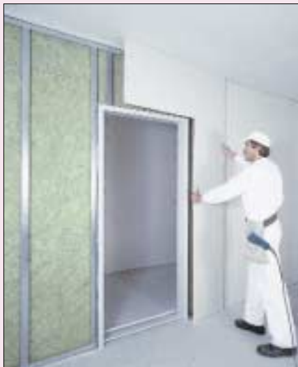
3 ...do budowy ścianek działowych... (fot. Polskie Stowarzyszenie Gipsu)
