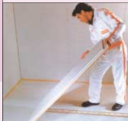
9 Płyty jastrychowe są często zespolone z materiałem termoizolacyjnym lub tłumiącym hałas (fot. Fels-Werke)
