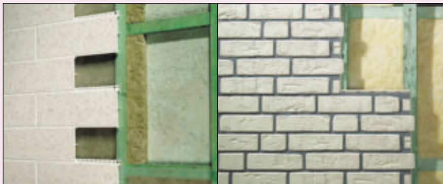
11 Okładzina z paneli z tworzywa z wtopioną warstwą kamienną (z prawej imitacja okładziny kamiennej) (fot. Polcommerce)
