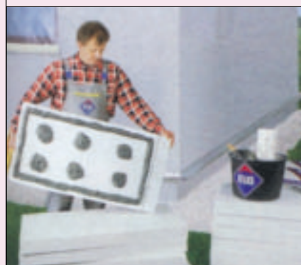
7 Bardzo ważne jest nakładanie kleju na obrzeża płyty (fot. Atlas)
