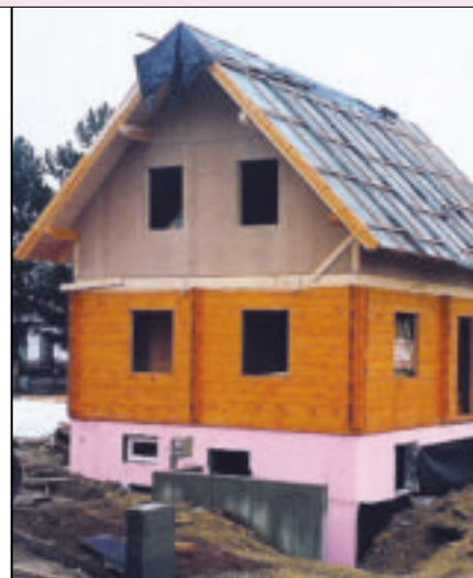
3 Ściany piwnic i cokoły najlepiej ocieplić płytami z polistyrenu ekstrudowanego, a ściany nadziemne wybranym systemem dociepleń (fot. Austrotherm)
