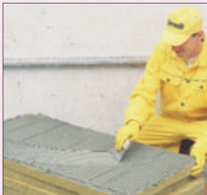
8 Nakładanie kleju na całą powierzchnię płyty pacą zębatą (fot. Henkel)
