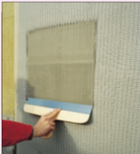
5 Zatapianie siatki zbrojącej w warstwie zaprawy klejowej (fot. Rockwool)
