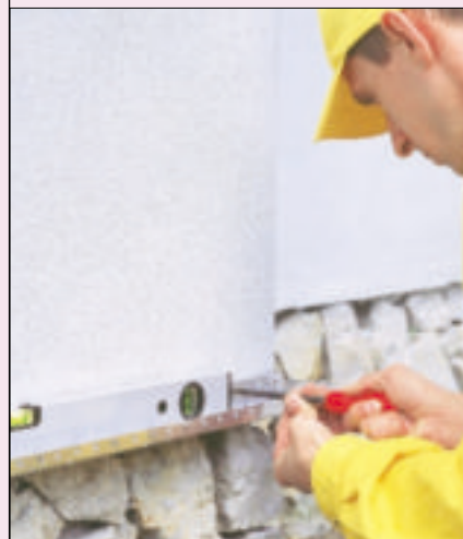
6 Listwy startowe trzeba zamontować bardzo starannie (fot. Henkel)
