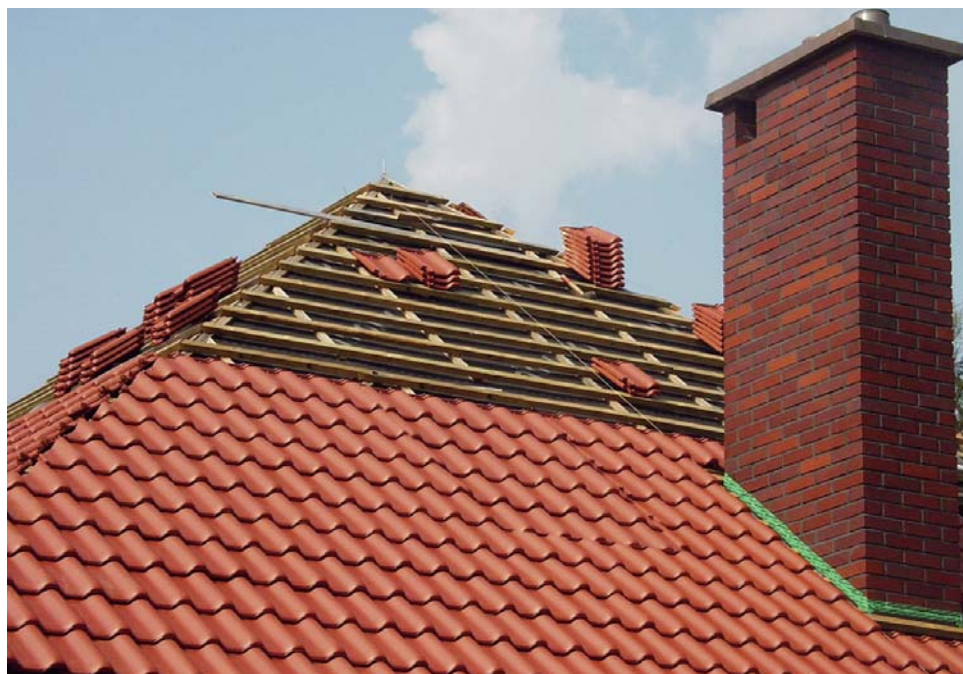
▲ Stosowanie wysokoparoprzepuszczalnych membran wstępnego krycia wymaga przepływu powietrza wentylującego między pokryciem i nad membraną. Zapewniają to kontrłaty z wlotem i wylotem utworzonej przez nie szczeliny
