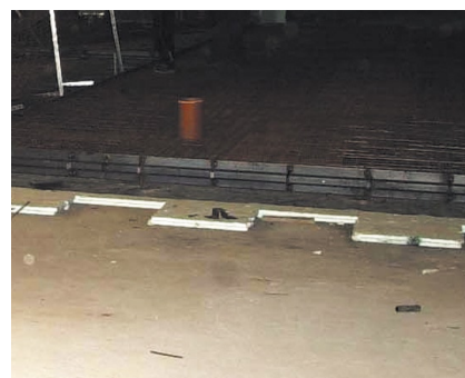
Fot. 2. Ocieplenie podłogi na gruncie
