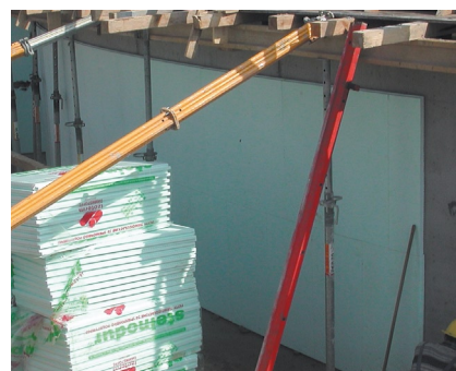
Fot. 1. Ocieplenie fundamentu
