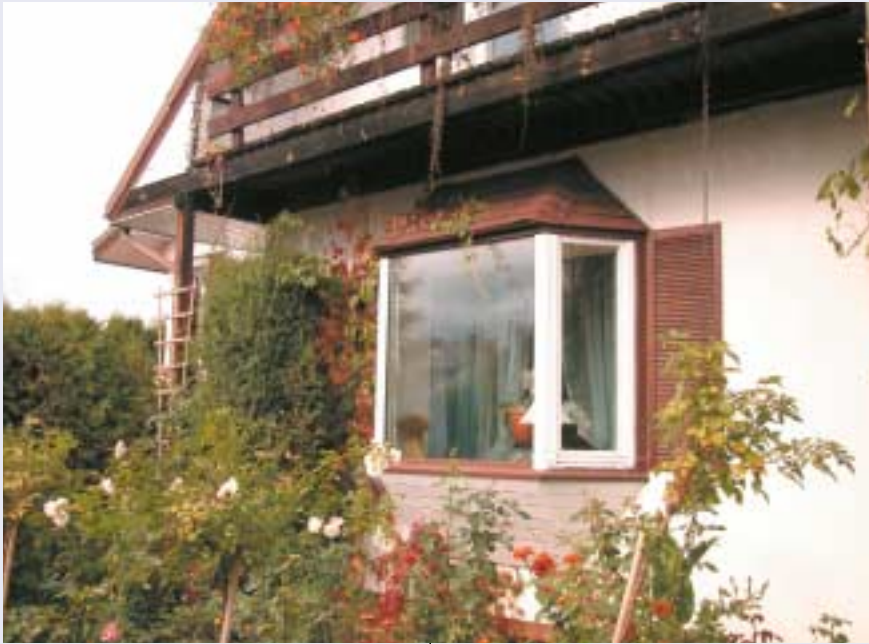
1 Dom można zabezpieczać na różne sposoby: a) mechanicznie (fot. Wiktor Strumiłło) i b) elektronicznie (fot. Istpol)
