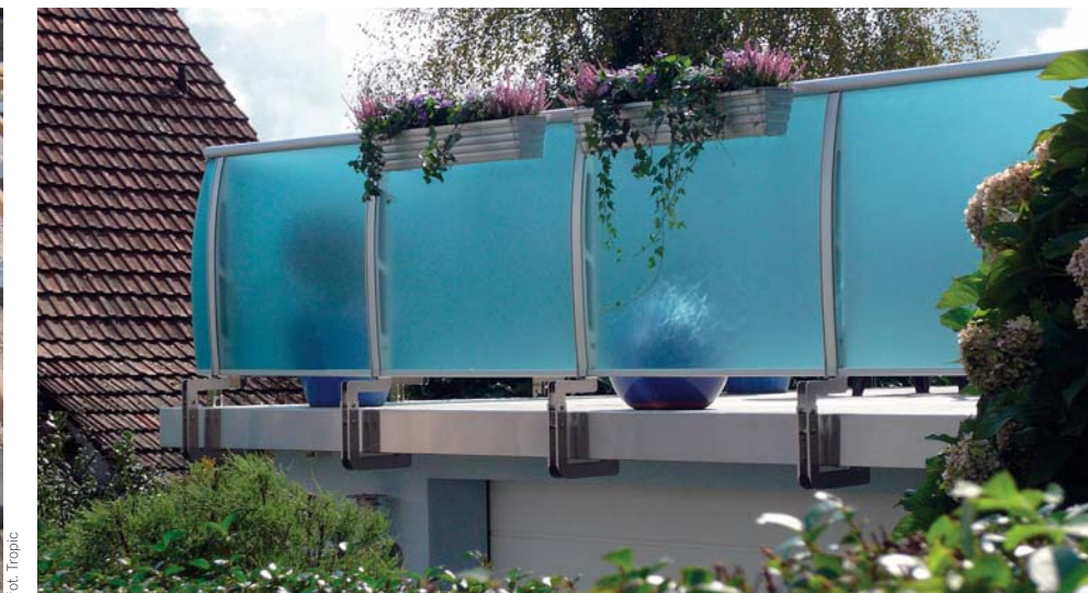
▲ Mocowanie balustrady od spodu płyty betonowej
