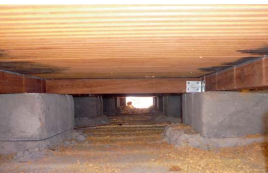
▲ Podkonstrukcja tarasu naziemnego
