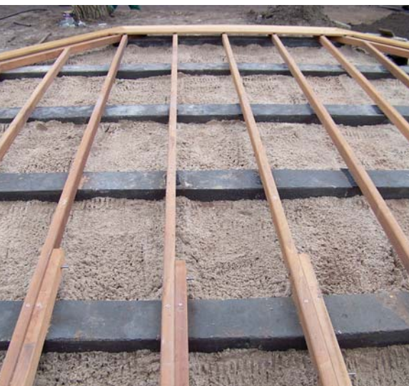
▲ Legary pod konstrukcję drewnianego tarasu naziemnego
