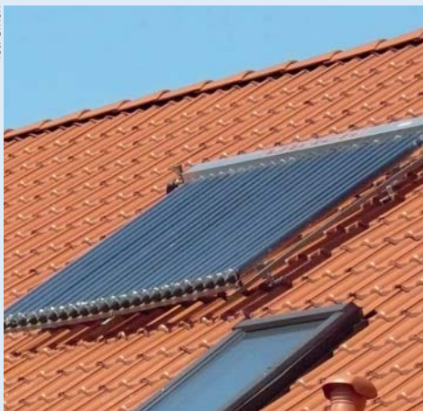
Kolektory słoneczne umieszczone na najbardziej nasłonecznionej, południowej połaci dachu mogą być źródłem znaczących zysków ciepła
