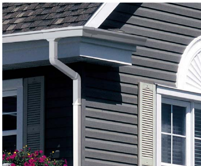
▲ Rynny z aluminium są bardzo popularnym systemem odprowadzającym wodę z dachów domów szkieletowych (tzw. kanadyjczyków)
