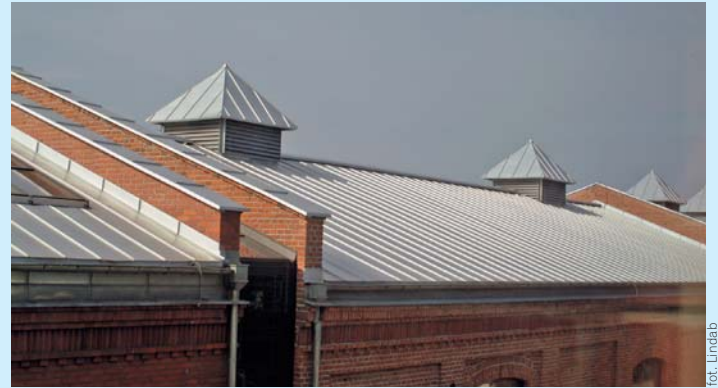
▲ Blachy aluminiowe nie są zbyt popularne, ale dzięki charakterystycznej barwie mogą być znakomitym uzupełnieniem ciekawego budynku
