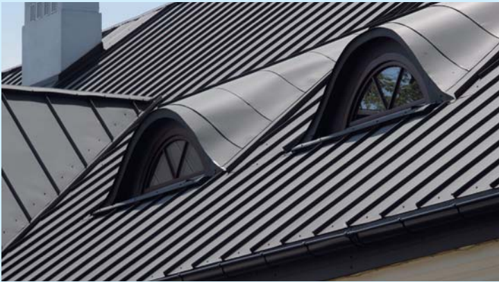
▲ Z blachy stalowej powlekanej można wykonać bardzo atrakcyjne pokrycie dachu nawet wielopłociowego lub ozdobionego lukarnami
