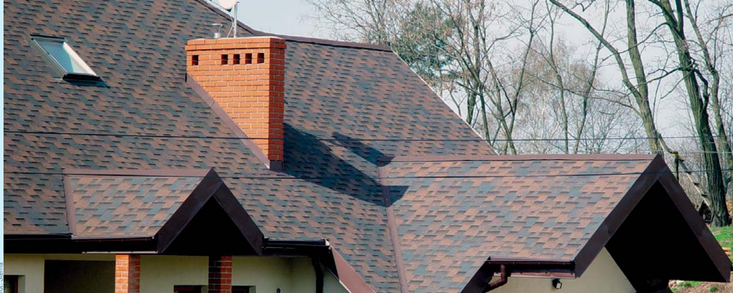
▲ Dachówki bitumiczne świetnie nadają się do krycia dachów wielopołaciowych, z dużą liczbą koszy, których nie trzeba wykańczać obróbką blacharską
