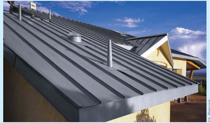
▲ Dach kryty płaską blachą cynkowo-tytanową nie tylko jest trwały, ale jeszcze wygląda bardzo nowocześnie
