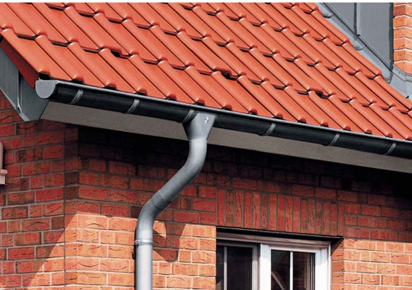
▲ Rynny z blachy cynkowej lub cynkowo-tytanowej są trwałe, estetyczne i doskonale pasują do dachu krytego dachówkami
