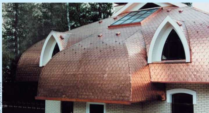
▲ Dachówki bitumiczne z folią metalową doskonale imitują bardzo drogie pokrycie blaszane, na dodatek świetnie sprawdzają się na krzywoliniowych połaciach
