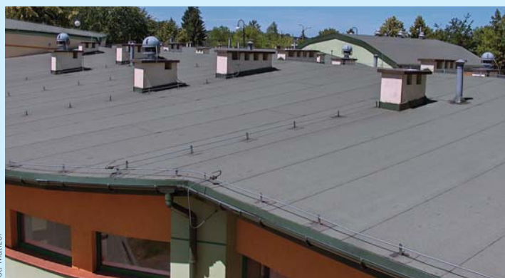
▲ Tradycyjne pokrycie z papy (najlepiej termozgrzewalnej) jest niezastąpione przy kryciu dachów płaskich
