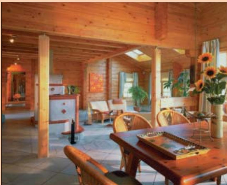
10 Grube bale, bez dodatkowego ocieplenia, nadają wnętrzem niepowtarzalny charakter (fot. Findrewno)
