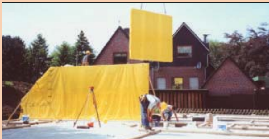
2 Przywiezione z fabryki elementy ściennie montuje się do fundamentów specjalnymi kotwami za pośrednictwem drewnianej belki podwalinowej (fot. Vidal)
