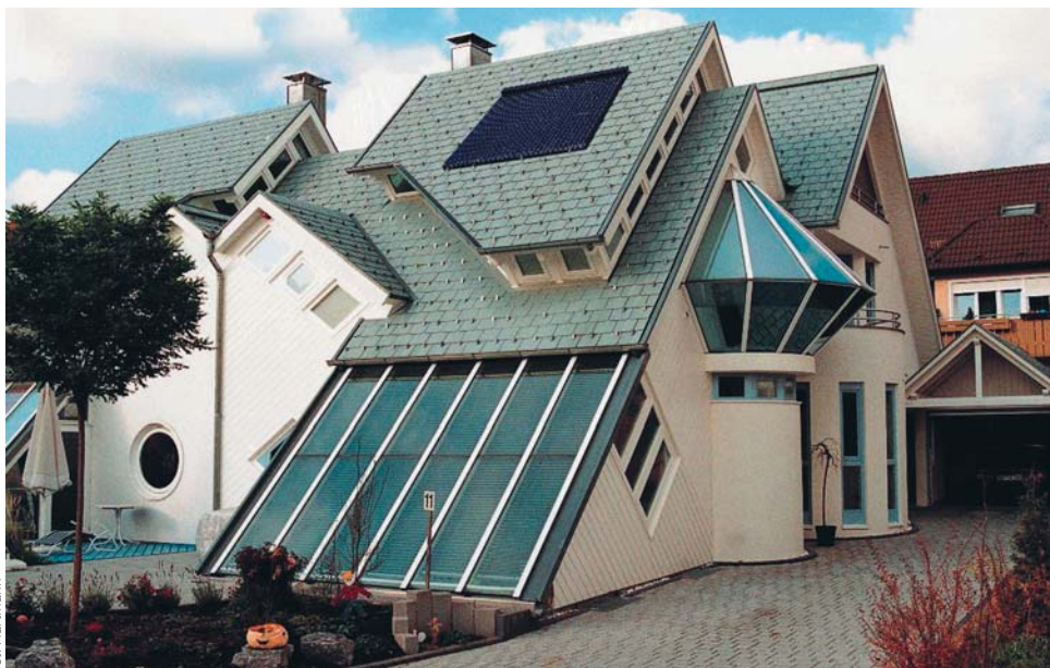
▲ Ogród zimowy i próżniowe kolektory słoneczne jako znamiona energooszczędności
