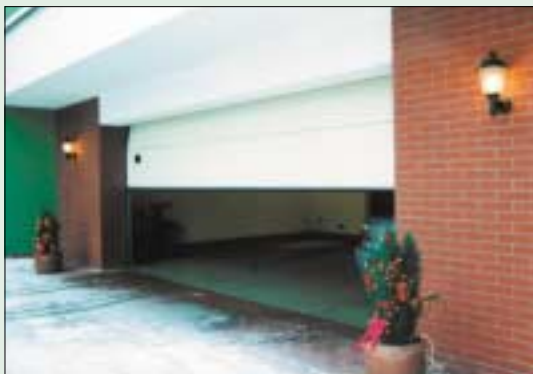
2 Szeroki wjazd do garażu powinien być oświetlony dwiema lampami (fot. Wimont)
