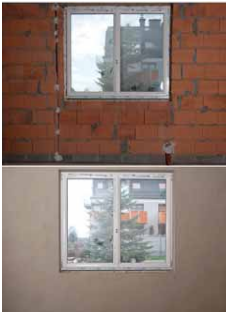
📍 Ściana przed i po tynkowaniu.
