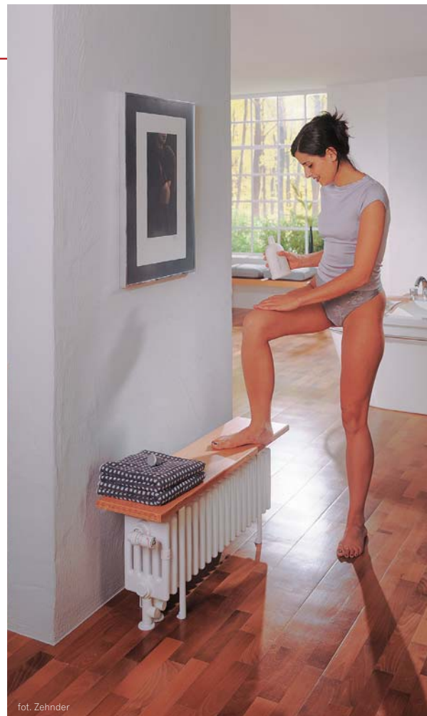
Grzejnika nie należy szczelnie obudowywać, ponieważ ograniczy to znacznie jego moc cieplną
