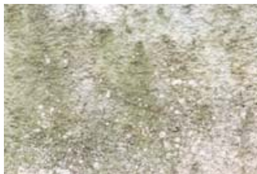
Powłoka malarska zniszczona przez glony i grzyby.
