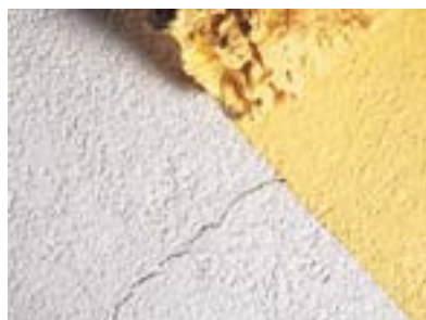
Pewne przekrycie rys na elewacji z użyciem specjalnych farb Sto-ispo - StoSilco Elast
