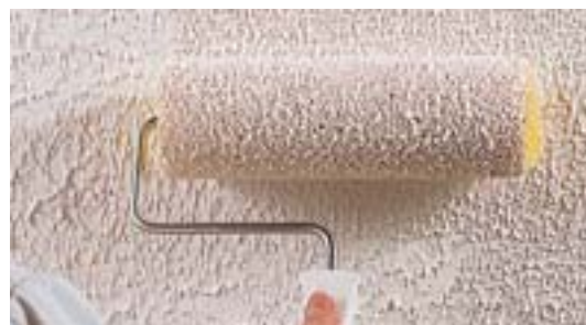
Farby z wypełniaczami StoSil Fill oraz StoSilco Fill umożliwiają uzyskiwanie różnych efektów fakturalnych
