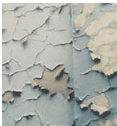
Złuszczenie farb o zbyt niskiej paroprzepuszczalności
