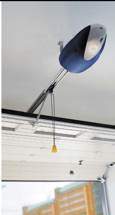
Siłownik elektromechaniczny do bram garażowych uchylnych i sekcyjnych
