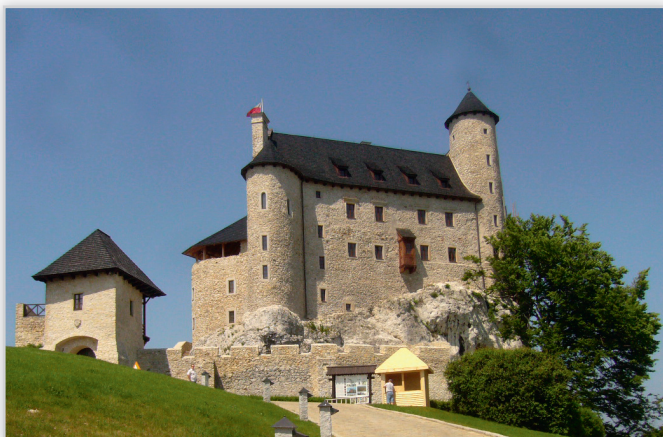
Zamek w Bobolicach. Zastosowany preparat: impregnat SARSIL®H-16/S.
