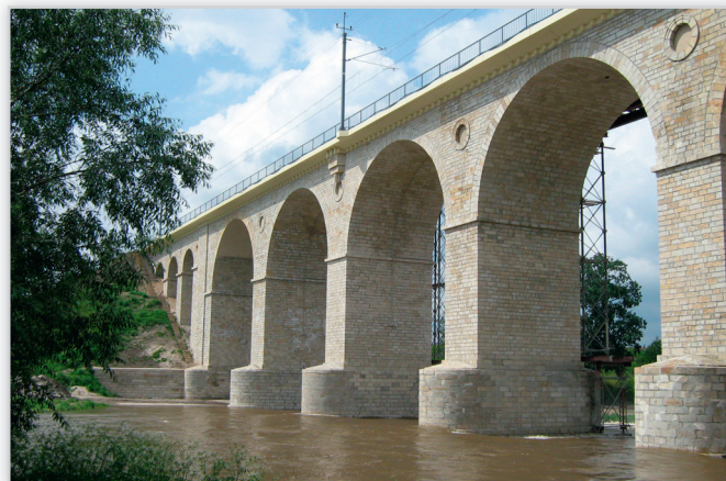
Most w Bolesławcu. Zastosowany preparat: impregnat SARSIL®H-14/R.
