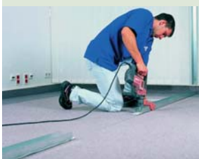
B Mocowanie profilu UW na podkładce wyciszającej z taśmy uszczelniającej (fot. Rigips)
