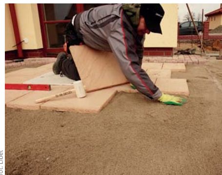
Układanie płyt tarasowych na przygotowanym podłożu
