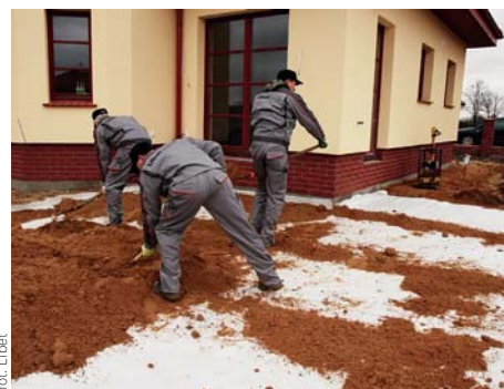
Wysypywanie na geowłókninie zagęszczonego piasku (zamiast piasku można użyć pospółki)
