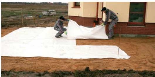
Układanie geowłókniny...
