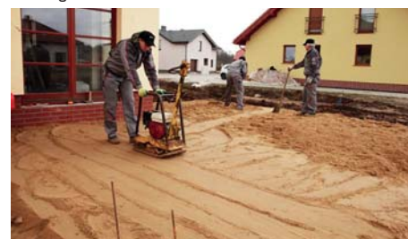
Mechaniczne zagęszczanie piasku formującego spadek
