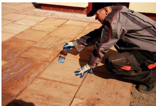
Układanie płyt tarasowych z zachowaniem 10-milimetrowych szczelin między nimi
