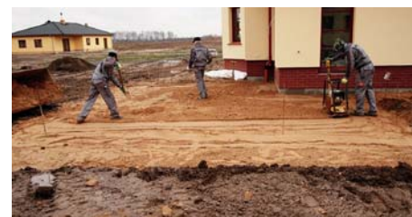
Wybieranie z wyznaczonej powierzchni gruntu rodzimego
