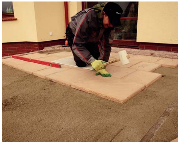
Układanie płyt tarasowych z zachowaniem 10-milimetrowych szczelin między nimi
