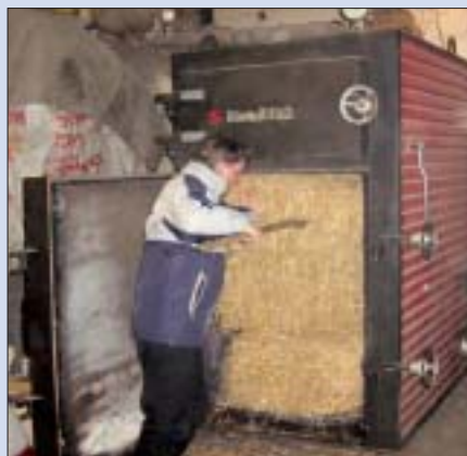
6 Kocioł załadowany balotami ze słomy (fot. Metalerg)
