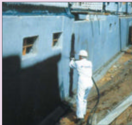
3 Emulsję izolacyjną można nanosić metodą natryskową (fot. Remmers)
