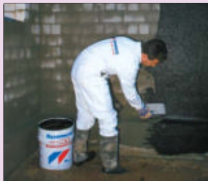
2 Masy bitumiczne nanosi się za pomocą szczotki lub pacy (fot. Remmers)
