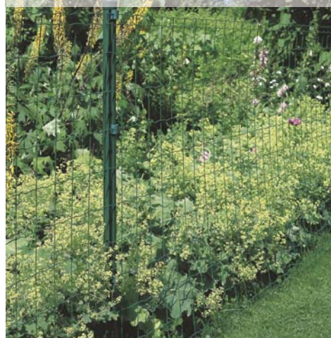
Panele z siatki montuje się między słupkami murywanymi lub metalowymi; te ostatnie wykonuje się najczęściej z kształtowników o przekroju zamkniętym i zasłania od góry kapturkiem
