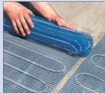
B Elektryczne ogrzewanie podłogowe z matą grzejną (fot. Elektra)
