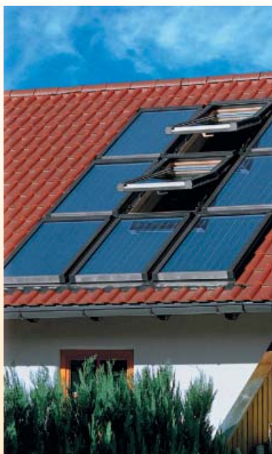
Kolektor słoneczny nie tylko ogrzewa wodę, ale stanowi także... ozdobę dachu (fot. Roto Frank Okna Dachowe)
