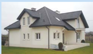
W domu o powierzchni użytkowej 150 m 2 i powierzchni ścian 230 m 2 średni koszt ścian to 38 000 zł
