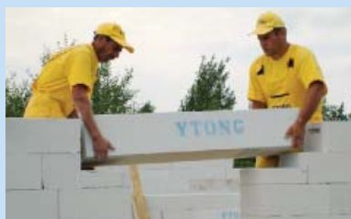
Nadproże do ścian jednowarstwowych (fot. Xella (Ytong))
