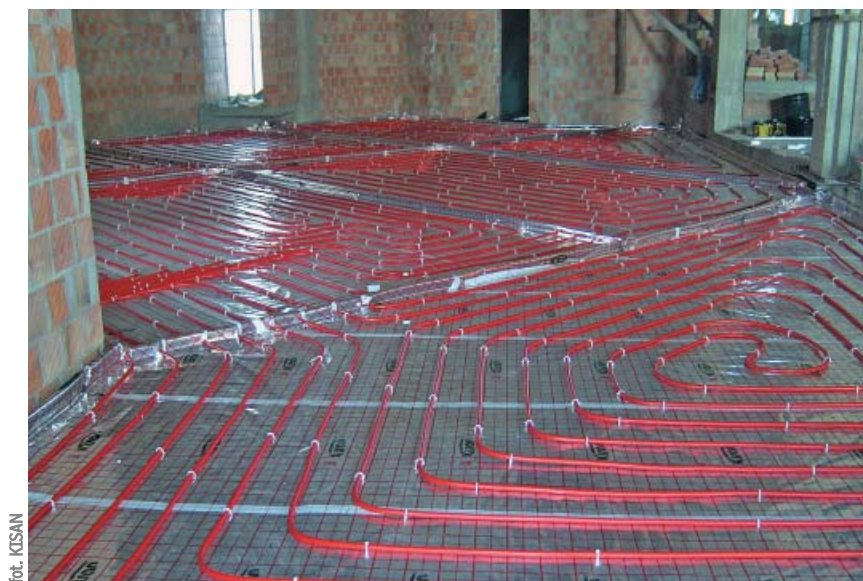
▲ Wodne ogrzewanie podłogowe ułożone w salonie to przyjemny komfort ciepłej podłogi
