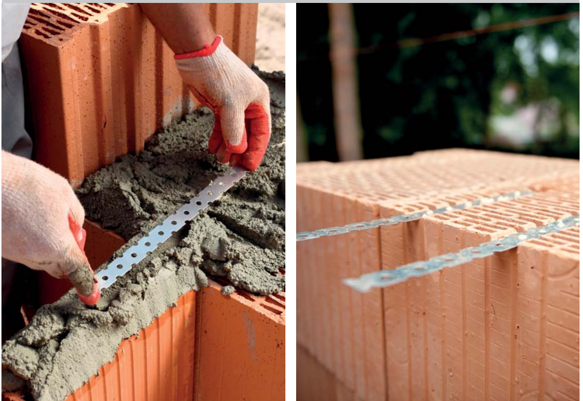
Rys. 9. Przykład zastosowania kotew stalowych w połączeniu ścian murowanych na zaprawie tradycyjnej i cienkospoinowej
