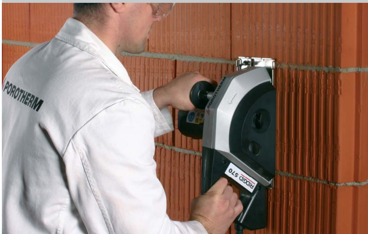
Rys. 10. Przykład wykonywania mechanicznej bruzdy pionowej w ścianie murewej Porotherm
