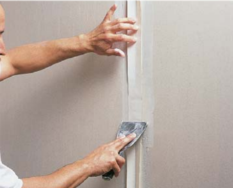
Wklejenie taśmy papierowej szorstką stroną do ściany
