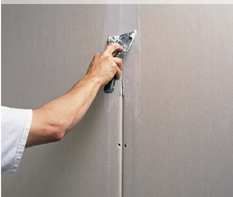
Wypełnienie spoiny masą szpachlową
