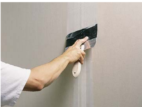
Nakładanie kolejnej warstwy masy szpachlowej (po wyschnięciu warstwy z wklejoną taśmą) na szerokość ok. 25 cm
