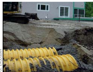
Komora obsypana tłuczniem
