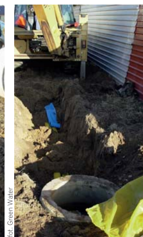
foto: Green Water Zagłębienie kręgów betonowych w wykopie
