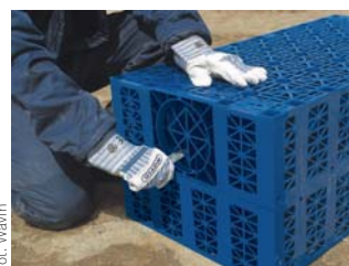
Wycinanie otworu w skrzynce rozsączającej
