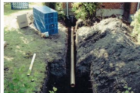
Wykop na skrzynkę rozsączającą
