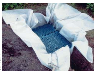
Umieszczenie skrzynki w dole wyłożonym geowłókniną z zapasem
