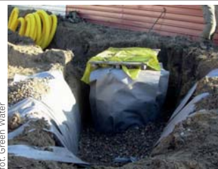
foto: Green Water Wykop przysypany żwirem
