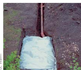
Skrzynka owinięta geowłókniną na zakładkę
