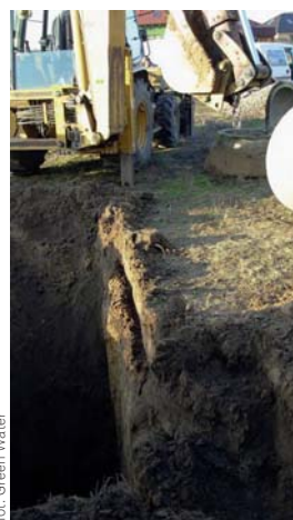
foto: Green Water Wykop pod studnię chłonną z kręgów betonowych
