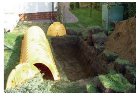
Wykop na komorę rozsączającą
