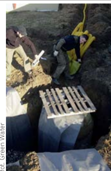
foto: Green Water Studnia i wykop zabezpieczone geowłókniną
