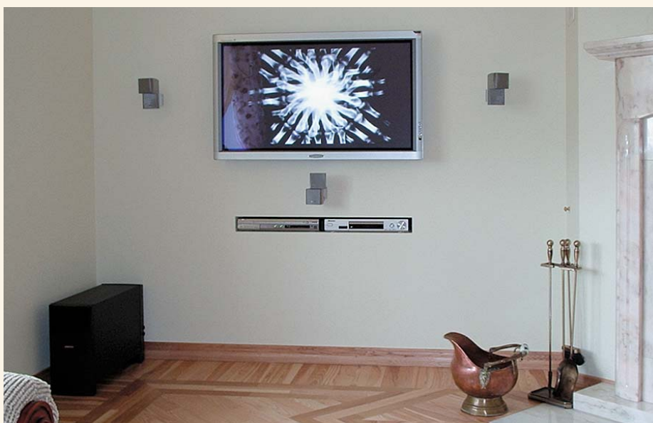
Efekt końcowy po instalacji wykonanej przez firmę ARTOM BIS
