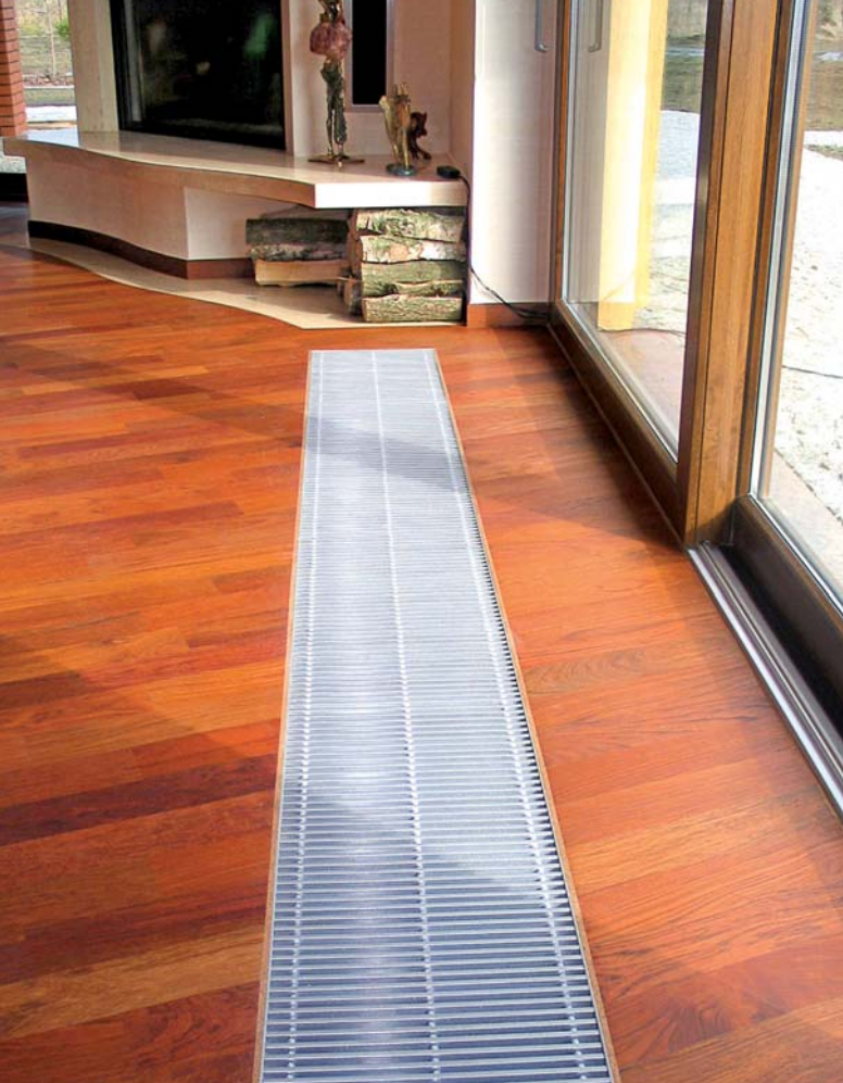
Ogrzewanie kanałowe może pełnić funkcję ogrzewania samodzielnego lub wspomagającego.
