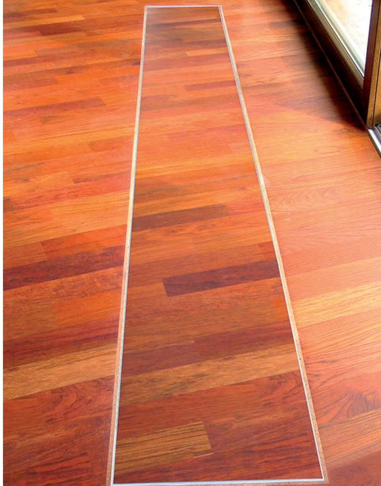
Podest posezonoowy maskuje i chroni wannę kanału przed zabrudzeniem po zakończonym sezonie grzewczym.
