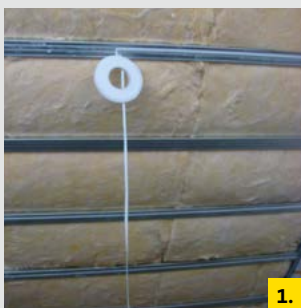
1. Przyklejanie taśmy ISOVER Vario® XtraFix do profili metalowych.
